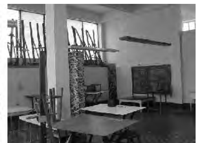
Ingreso de luz natural a través de las ventanas superiores y distribución por muros.
