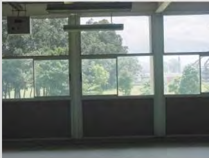
Vista desde el interior
