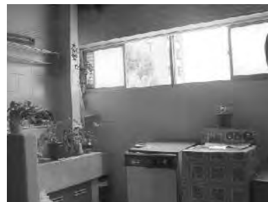
Efecto del vidrio grabado, habitualmente usado solo para lograr privacidad visual.
