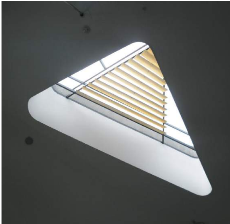
4. Fotografía del lucernario visto desde el interior del edificio. La estructura interna con las lamas de madera corresponde al sistema de protección solar.
