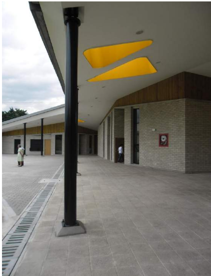
1. Fotografía a la primera Etapa, tomada desde el corredor sur.
